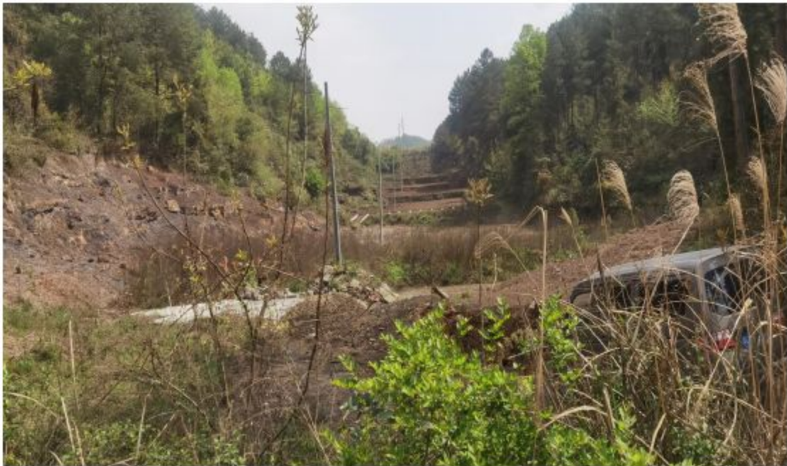
新增弃渣场照片（一）
